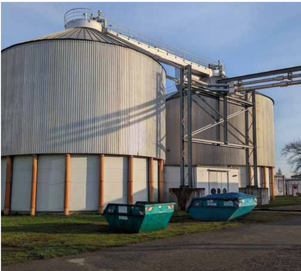
Faulbehälter, die zur Remobilisierung eingesetzt wurden im Großmaßstab am Standort Gifhorn. © P-Net
